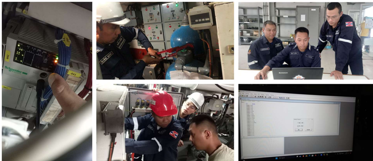
รูปที่ ๒๑ ตรวจสอบและซ่อมระบบควบคุมเครื่องผลิตน้ำจืดจากน้ำทะเลด้วยระบบ Reverse Osmosis ชุด ร.ล.สายบุรี
