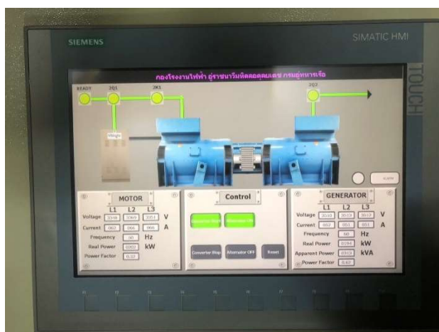
รูปที่ ๖ การออกแบบหน้าจอ HMI ของระบบควบคุมเครื่องแปลงความถี่ไฟฟ้า (MG-SET) (รูปซ้าย) เครื่องตัดแผ่นเหล็ก (รูปขวา)
