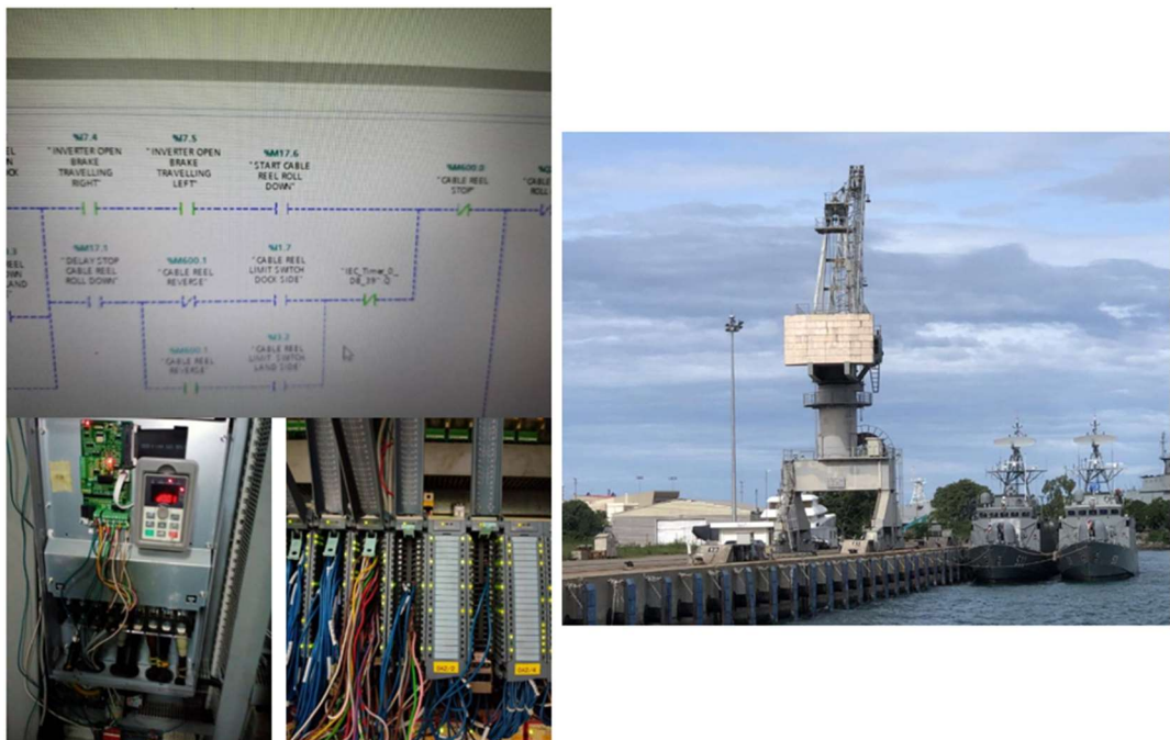
รูปที่ ๒๘ ซ่อมทำระบบควบคุม เครน 75 ตัน ประจำอู่ อรม.อร.
