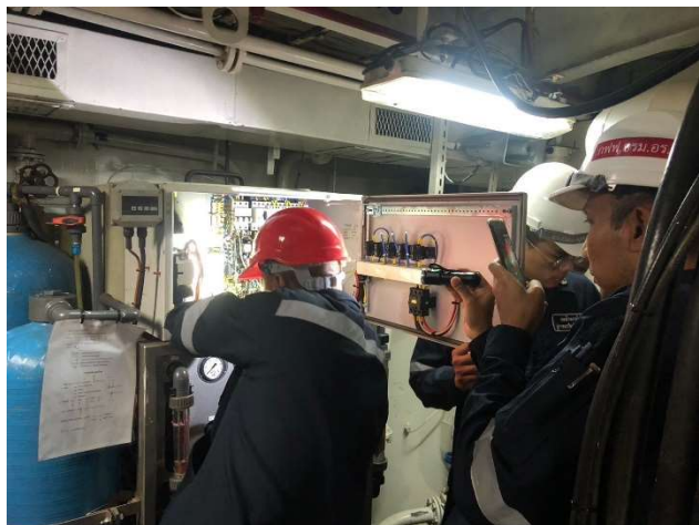
รูปที่ ๑๑ การเข้าตรวจสอบระบบควบคุม PLC
