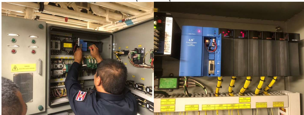
รูปที่ ๒๒ ตรวจสอบและซ่อมระบบควบคุมเครื่องผลิตน้ำจืดจากน้ำทะเลด้วยระบบ Reverse Osmosis ชุด ร.ล.ภูมิพล
