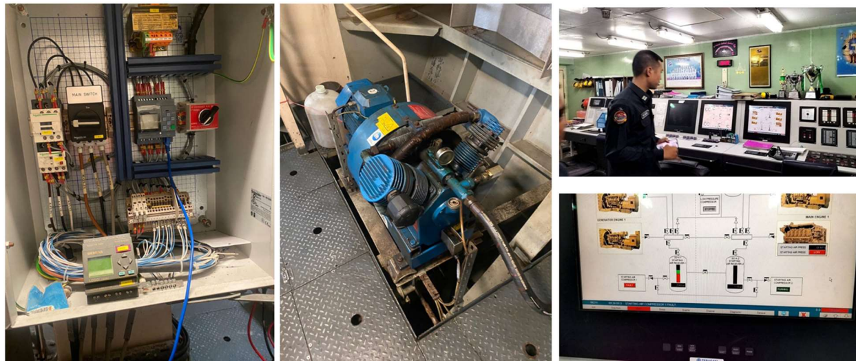
รูปที่ ๒๔ ตรวจสอบและซ่อมระบบควบคุมเครื่องอัดลมของ ร.ล.อ่างทอง
